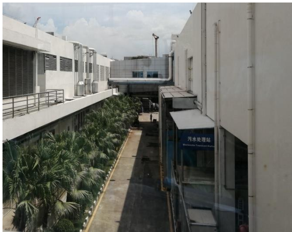
项目废水处理设施
