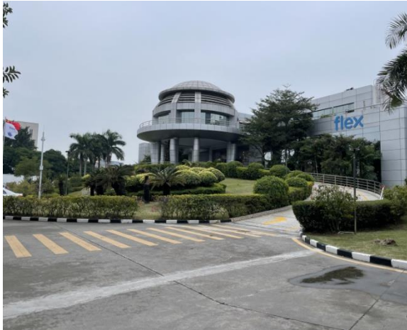
项目厂房外观
