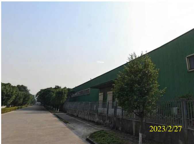
项目南面-鑫国邦物流园
